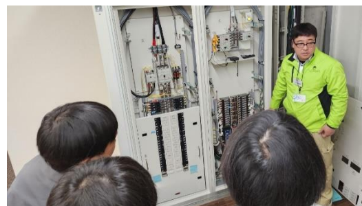
高校生対象・実技講習 & 建設現場見学会（令和 5 年実施）
